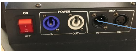
подключение машины через DMX-порт к контроллеру, который находится на площадке.
